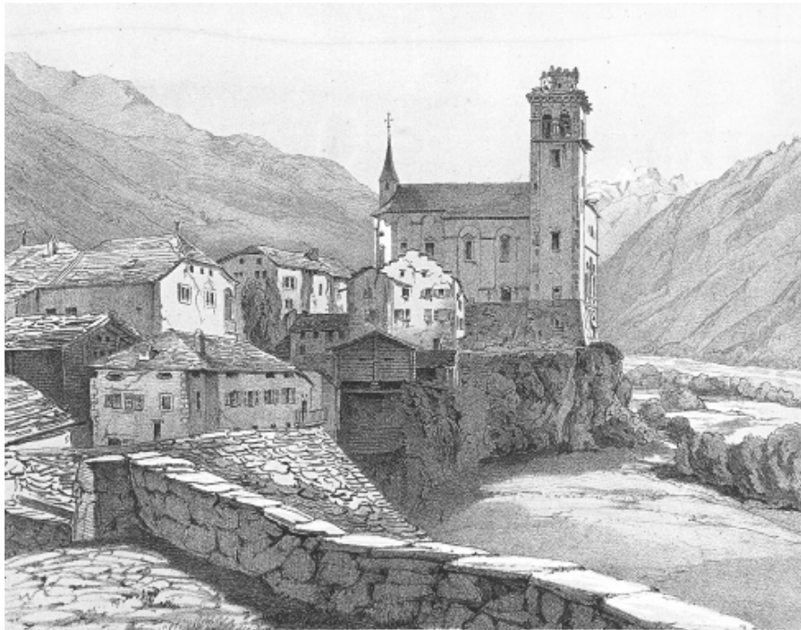
Historische Abbildung der Erdbebenschäden in Visp 1855: Viele Hausmauern sind von Rissen durchzogen und die Spitze des Kirchturmes ist eingestürzt.
